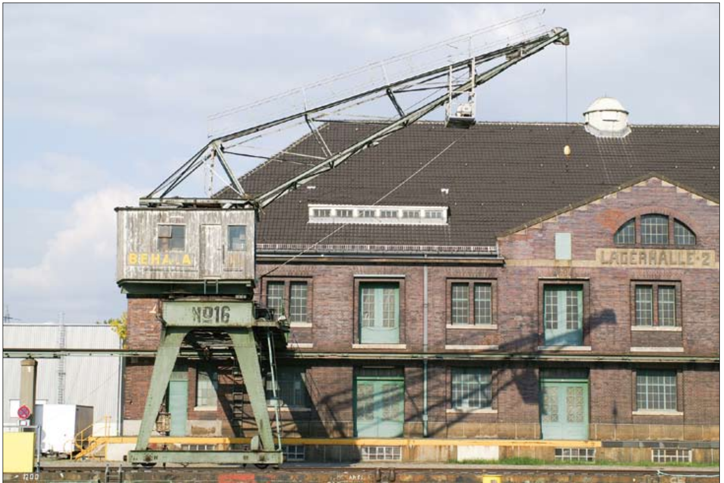
Kran 16: Gesamtansicht Süden
