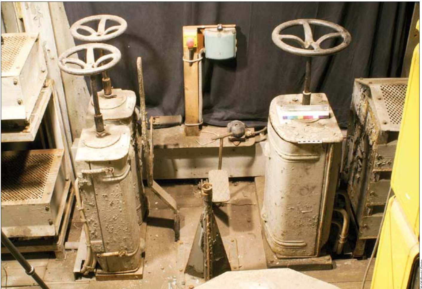
Ansicht der Steuereinrichtungen von Kran 16
